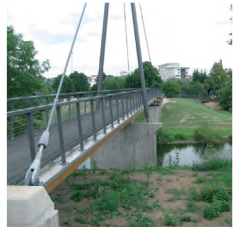
Hängebrücke in Wetzlar.
