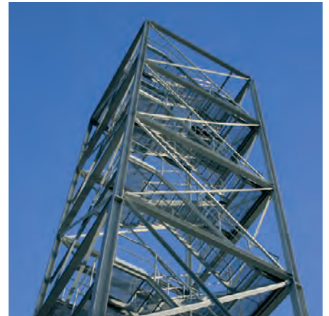
Treppenturm einer Silo-Lageranlage.
