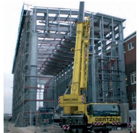
Neubau einer Halle für Schiffsbau mit einer Traufe von 20 Metern.
